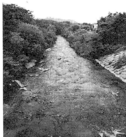
写真-3 改修区間
