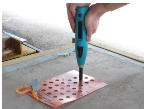
写真 5.4.1 表面反発強度測定状況
