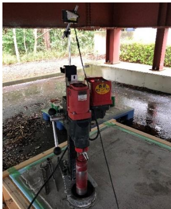
写真 5.2.3 コア削孔状況
