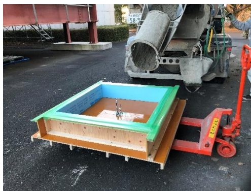
写真 5.2.1 試験体打込み前
