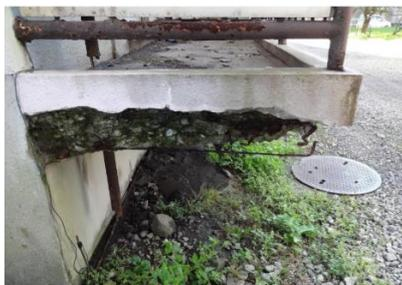
写真 1.2.1 凍害によるベランダの損傷
