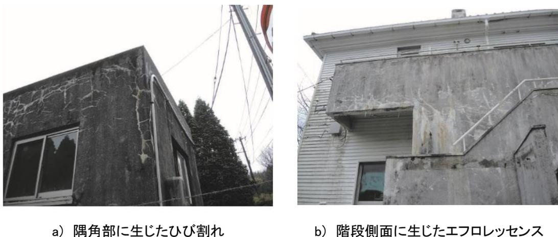
写真 1.2.3 九州における凍害劣化事例<sup>1.22)</sup>
