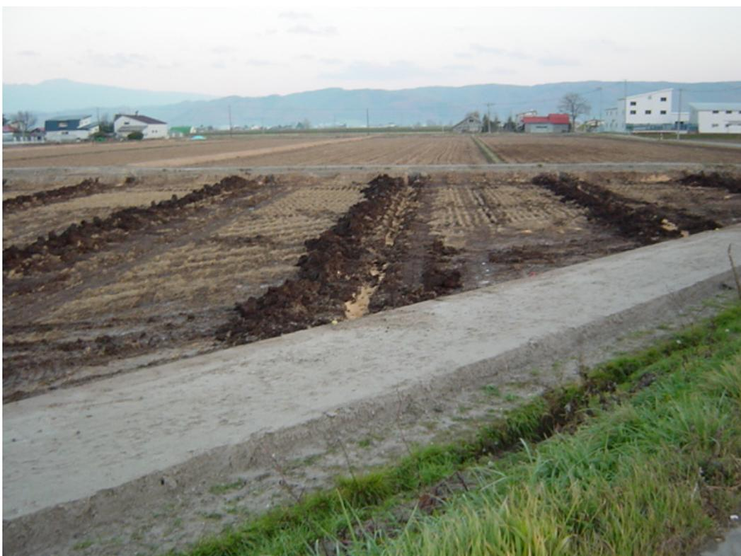
写真 2-6 暗渠工事（埋め戻し前）
