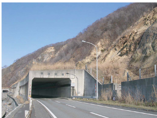
写真-1.1 ロックシェッドの一例
