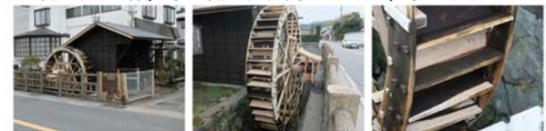
左: 車軸受け, 中: 水車骨組み, 右: 水車設置水路
