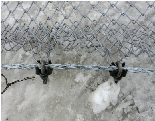
写真6 固定部の局所変形状況
