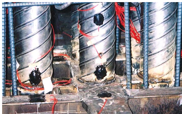
写真-1 鋼桁と鋼管の接合状況
