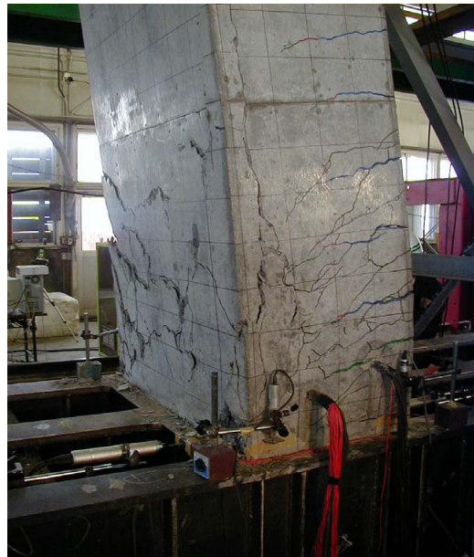
写真-2 実験終了後の供試体の損傷状況
