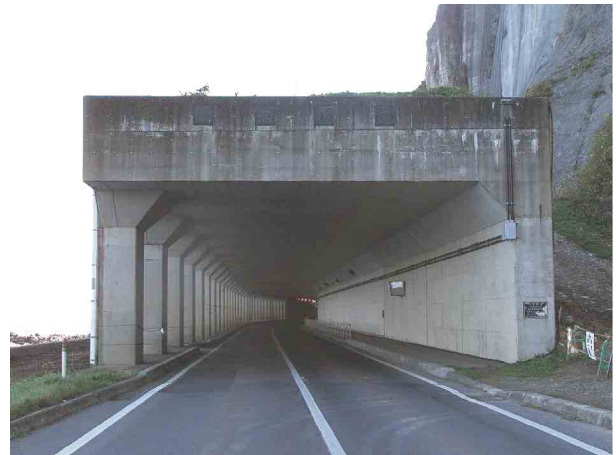
写真-1 落石防護覆道の一例
