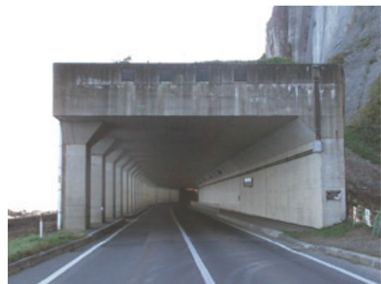
写真-1 落石防護覆道の例
