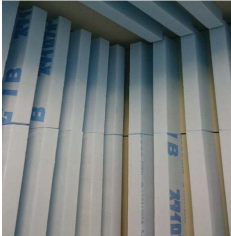
図 3 実験室の吸音加工
