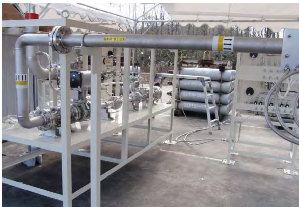
図1 GG-ATR エンジン冷走試験設備
