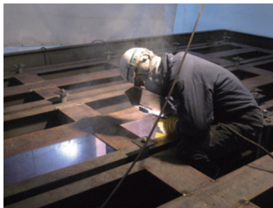
写真-3 実験装置 (SRC版) の製作状況
