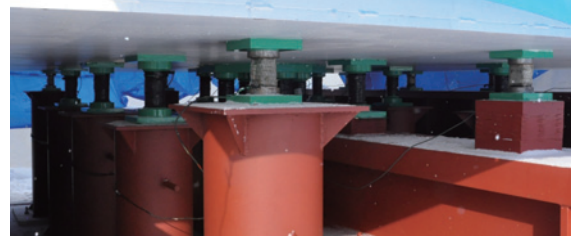
写真-5 衝撃荷重用ロードセルの配置状況
