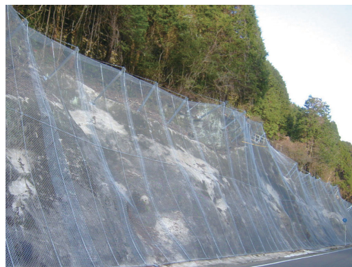
写真-1 ポケット式落石防護網
