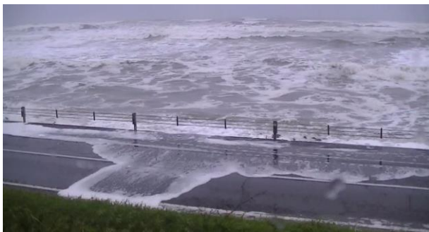
写真-2 高波浪時における道路上への越波状況
