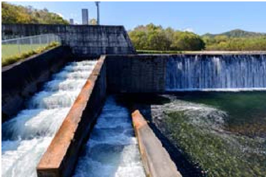
写真 4.5 砂防えん堤への魚道の設置事例 23)
