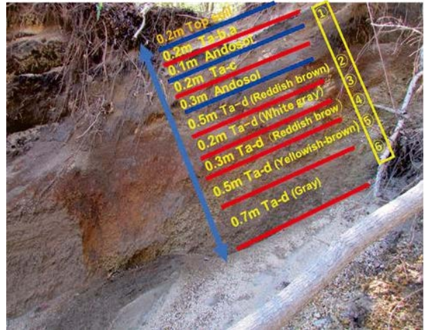
写真5 表層すべり崩壊現場の露頭部の状況
