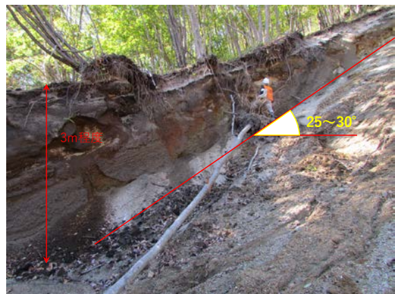
写真 4 表層すべり崩壊地点の露頭の様子
