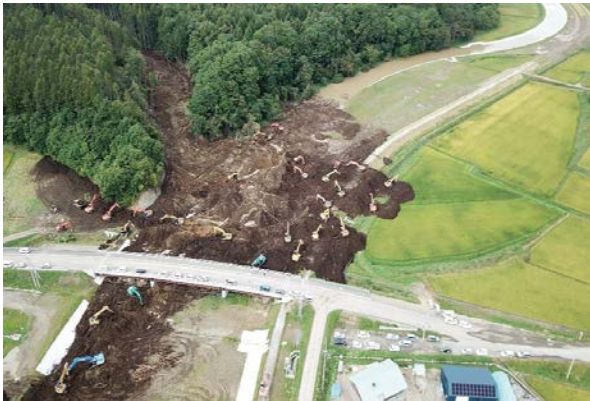
写真3 土石流による厚真川の河道閉塞
