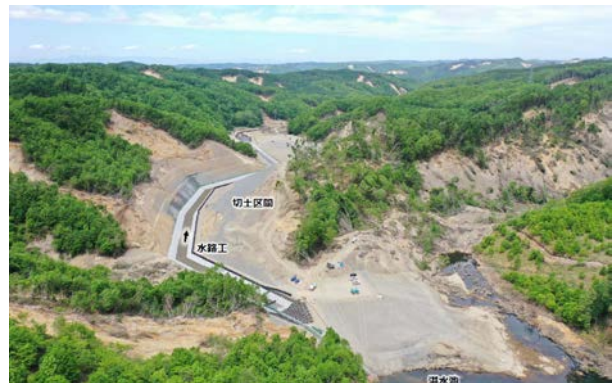
図7 日高幌内川上流部の復旧状況 (6)
