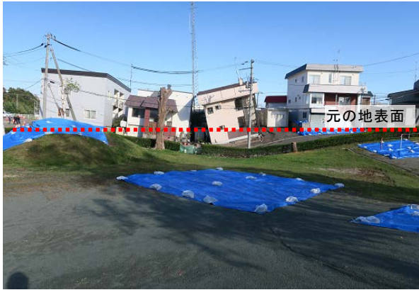
写真4 札幌市清田区里塚地区の地盤沈下状況
