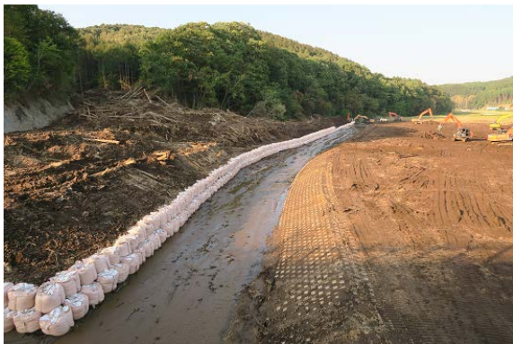
写真5 厚真川の仮復旧状況
