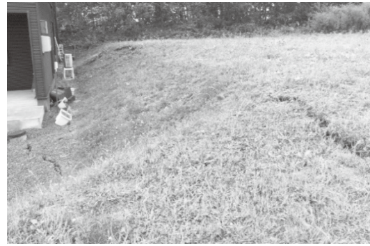
写真 3.4 建物の背面地盤での地割れ
