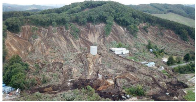
写真2 厚真町富里浄水場の斜面崩壊
