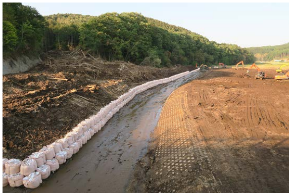
写真5 厚真川の仮復旧状況
