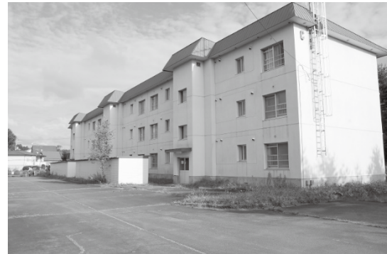
写真 3.5 RC 造 3.F 建物の全景
