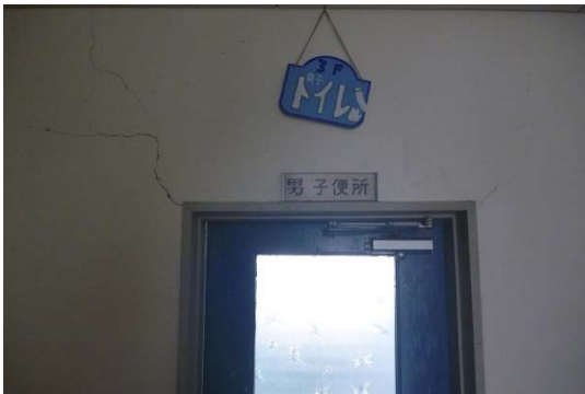
(c) 非構造壁の損傷-1
