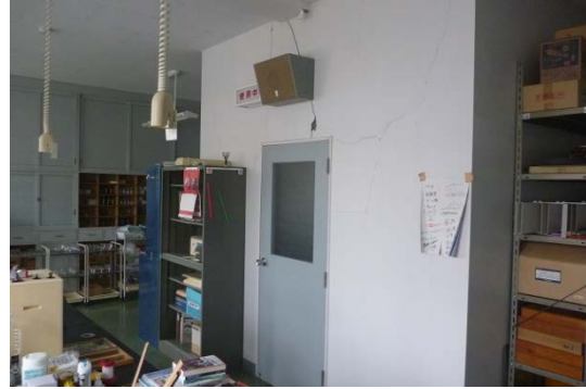
(b) 非構造壁の被害
