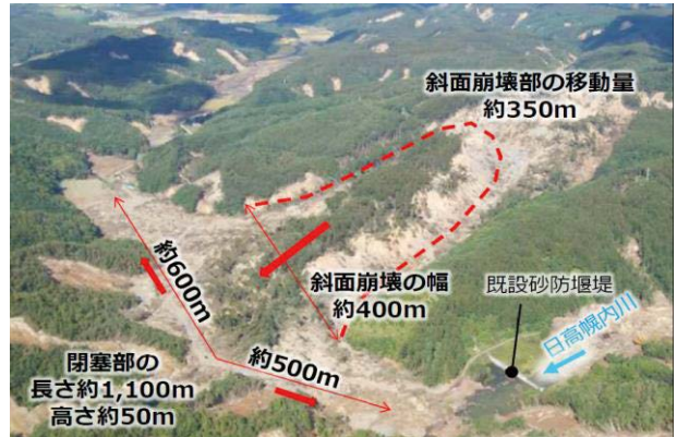
図5 日高幌内川上流部大規模地すべり(9)
