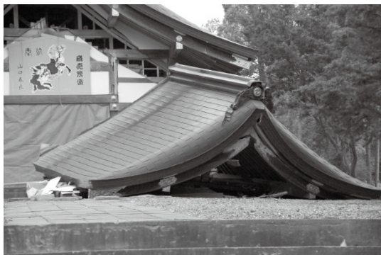
写真 3.15 社殿の崩壊（手前側）
