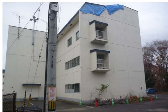
(f) 飾り壁の撤去後(H30.11 撮影)
