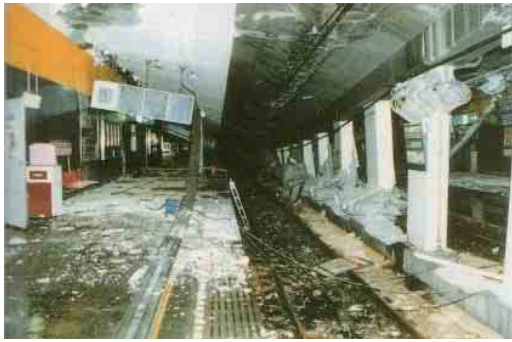
写真-2 神戸高速鉄道大開駅中柱被災状況
