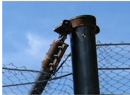
支柱頭部近傍
