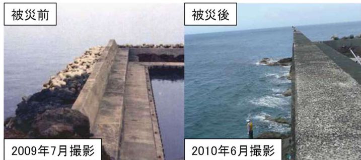
写真-2 消波ブロックの状況
