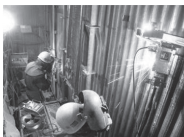
(a) ボイラ火炉内における肉盛溶接状況の一例
