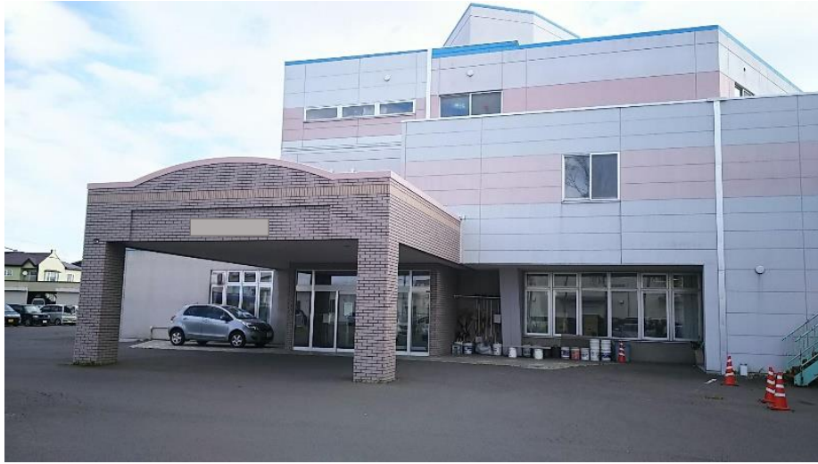
図 2.4-1 A 施設外観
