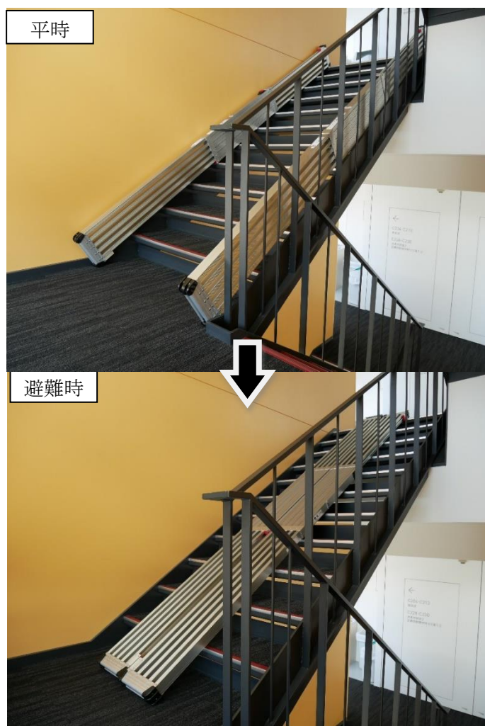
図 5.4-1 足場板の設置
