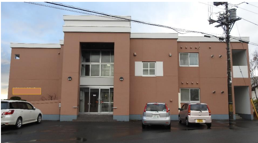
図 2.4-4 D 施設外観
