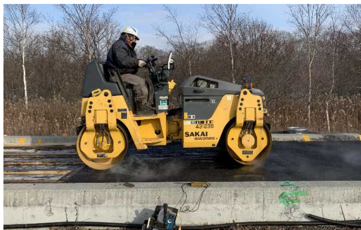
写真-8.3.11 試験舗装の施工状況
