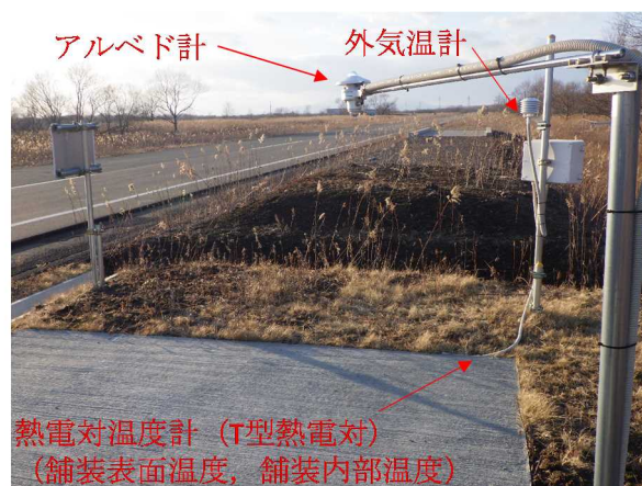
写真-6.1.1 対象施設における計測状況
