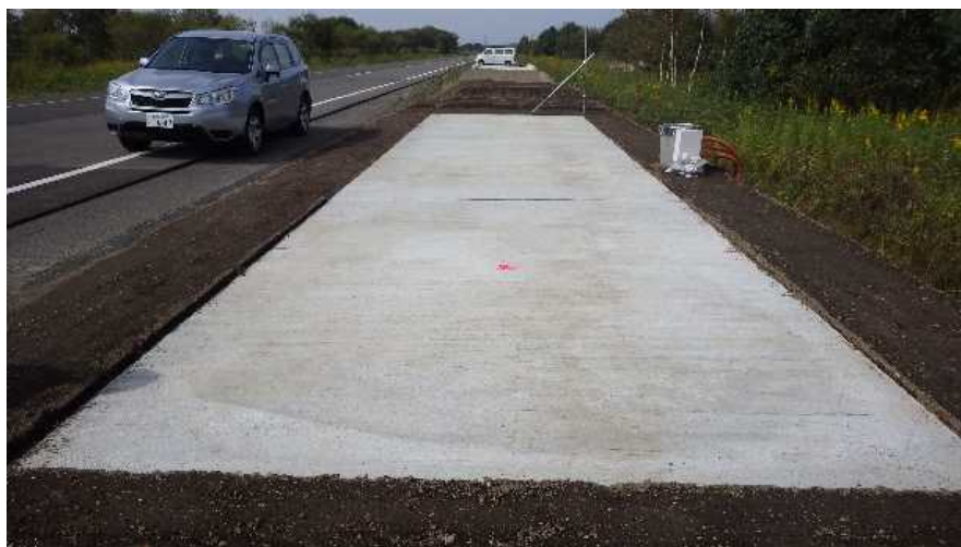
写真-5.4.1 計測対象施設の（コンクリート舗装版箇所）
