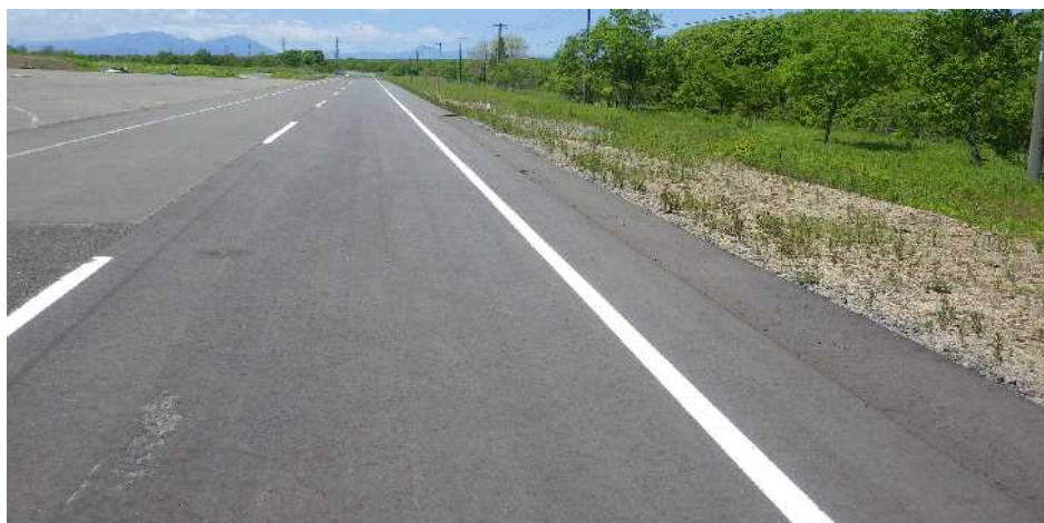
写真-5.7.2 アスファルト舗装部
