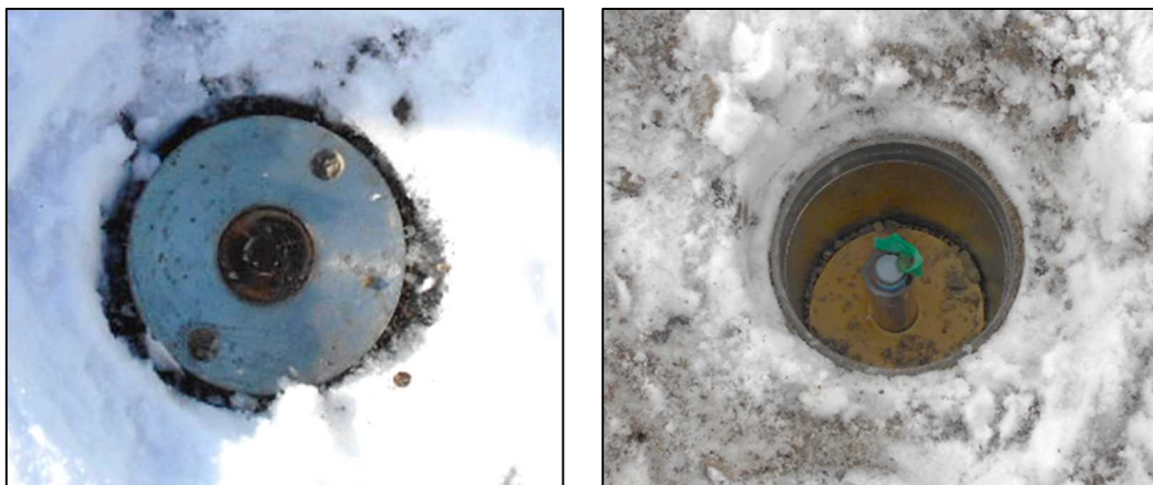
写真-5.7.5 メチレンブルー凍結深度計設置状況
