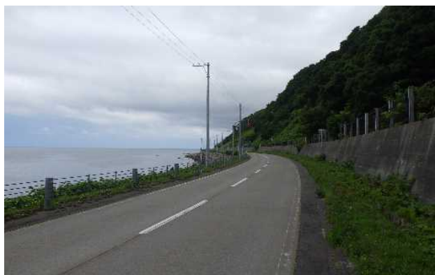
写真-4.3.1 増毛のコンクリート舗装区間の供用環境
