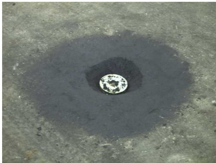
写真-5.7.1 メチレンブルー凍結深度計埋設用ハンドホール
