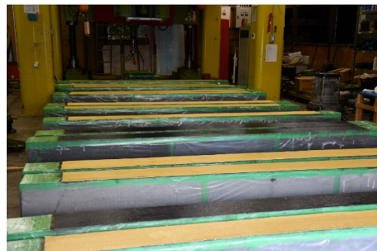
(d) Completion and curing
