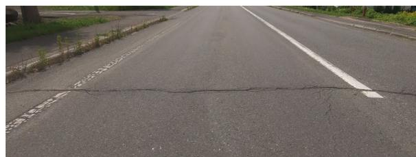
図-3 低温ひび割れの例
