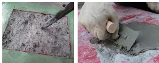
(a) 劣化部除去の様子 (b) 断面補修材
