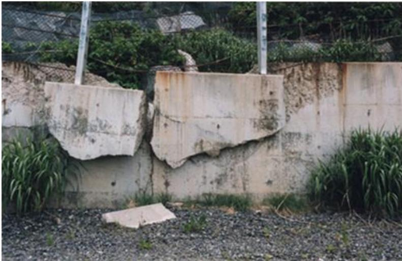
写真-1.1 落石防護擁壁の損傷事例
