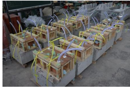
(d) Formwork of the new side
