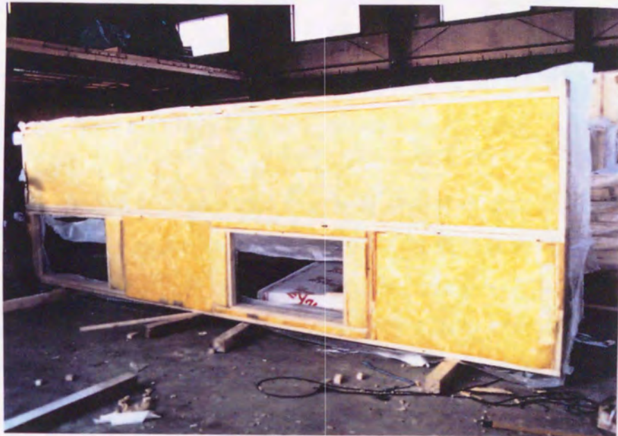
図 5 - 10 屋根パネルの組立状況、 開口部には天窓が付けられる
