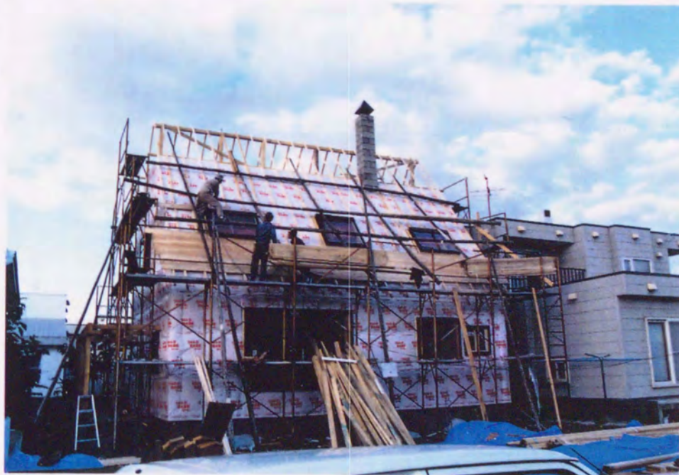
図 2 - 16 断熱工事、防風材取付工事が終了。 屋根下地を施工中。
