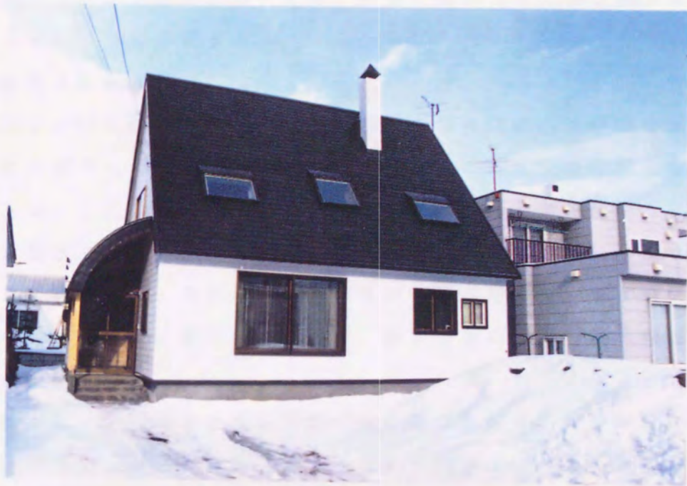
図 2 - 17 竣工後の南西面外観。
