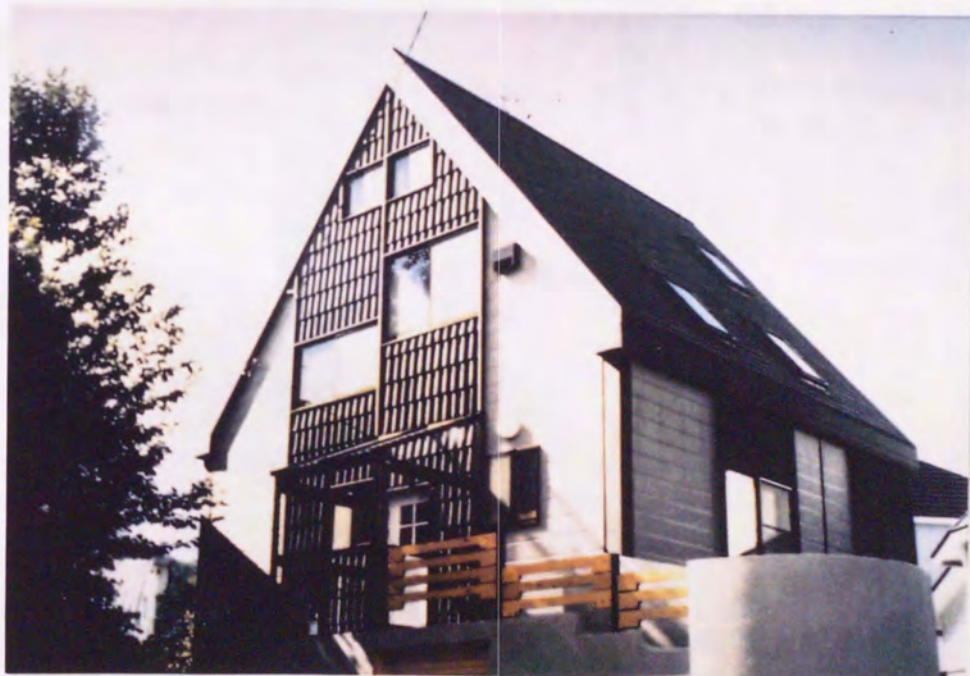
図 5 - 14 竣工後のU宅 北東面外観
