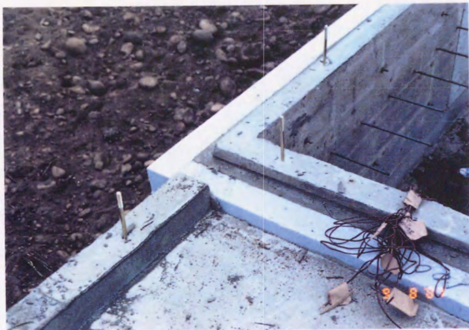
図 2 - 10 布基礎が断熱材（FP板 7100）で外断熱された状態。手前、土間コンは風除室の部分で断熱の外となる部分
