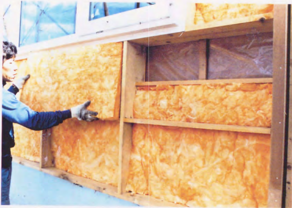
図 2 - 15 枠を組んだのち、断熱材を 2 層、計 200 ミリを施している状態。
