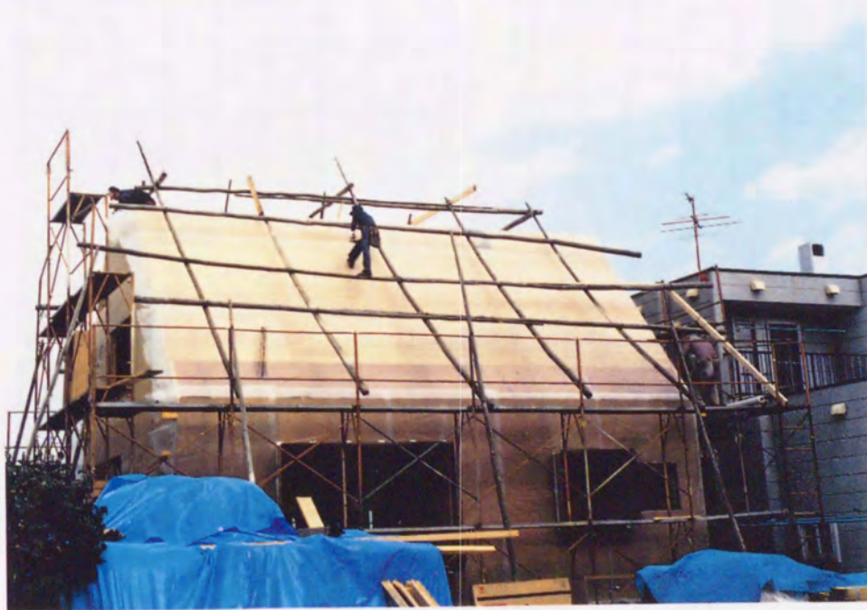
図 2 - 11 気密・防湿材を外側より施工。窓枠はこの時点で取り付けられている。
