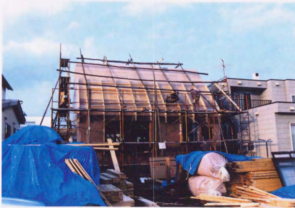
図 2 - 14 枿材が施工されている状態。
