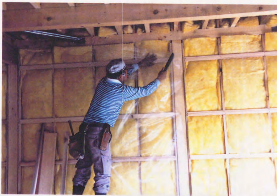
図1-10 在来構法住宅の防湿材を施工中。
