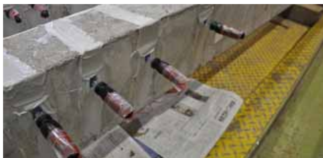
(d) Injecting epoxy-resin inside the cracks
