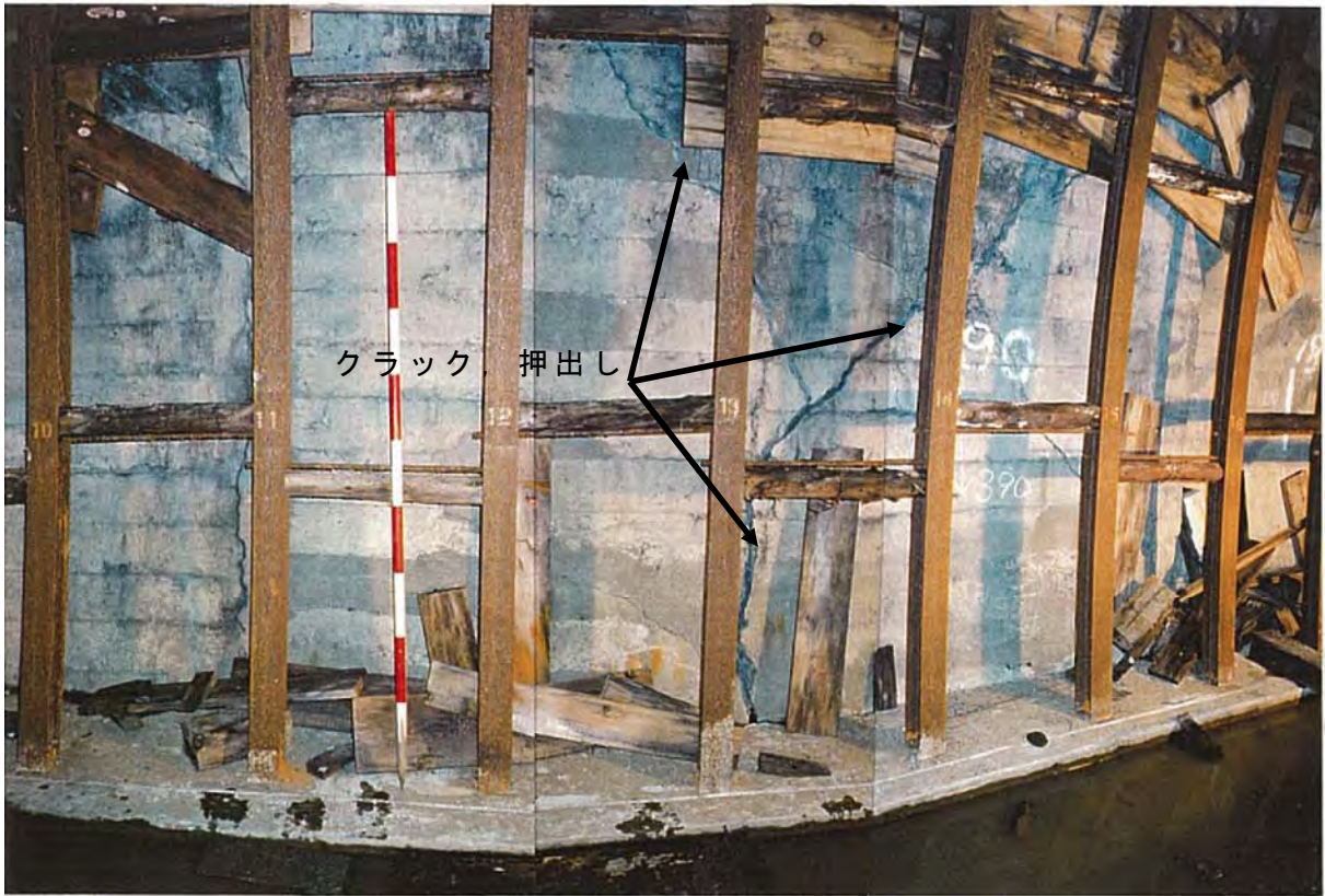
Photo4.1.18 既設トンネル SP388 付近左側の状況
