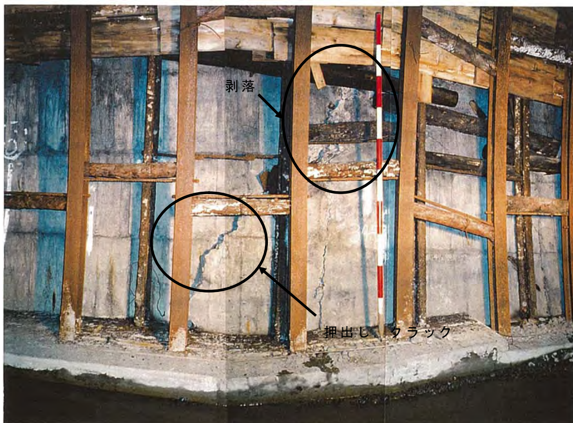
Photo4.1.16 既設トンネル SP345 付近右側の状況
