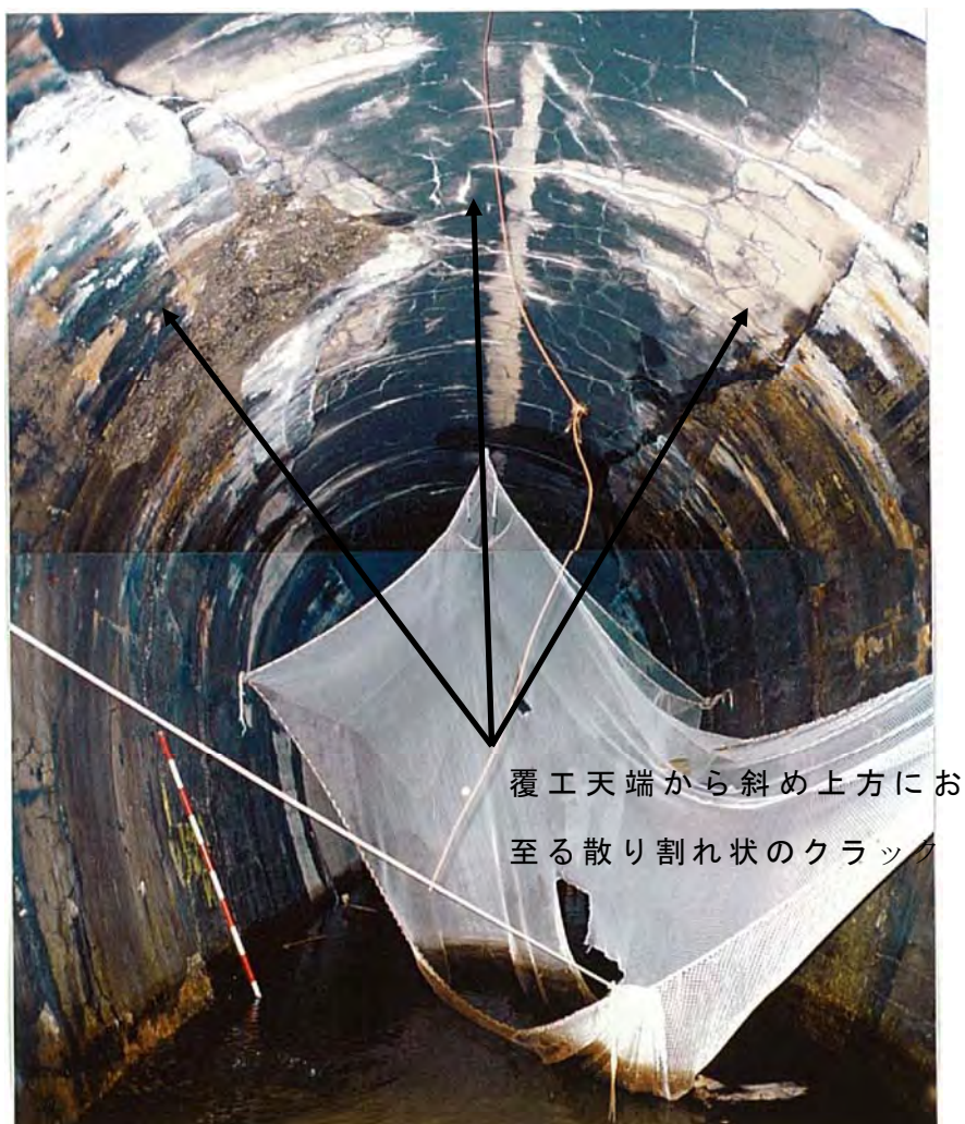
Photo4.1.21 既設トンネル SP450 付近の状況
