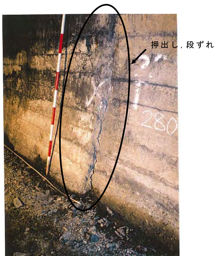
Photo4.1.10 既設トンネル SP280 付近右側の状況
