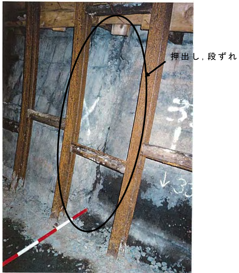
Photo4.1.14 既設トンネル SP330 付近右側の状況
