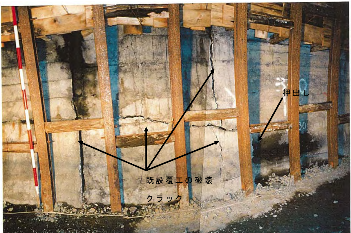
Photo4.1.15 既設トンネル SP332 付近右側の状況
