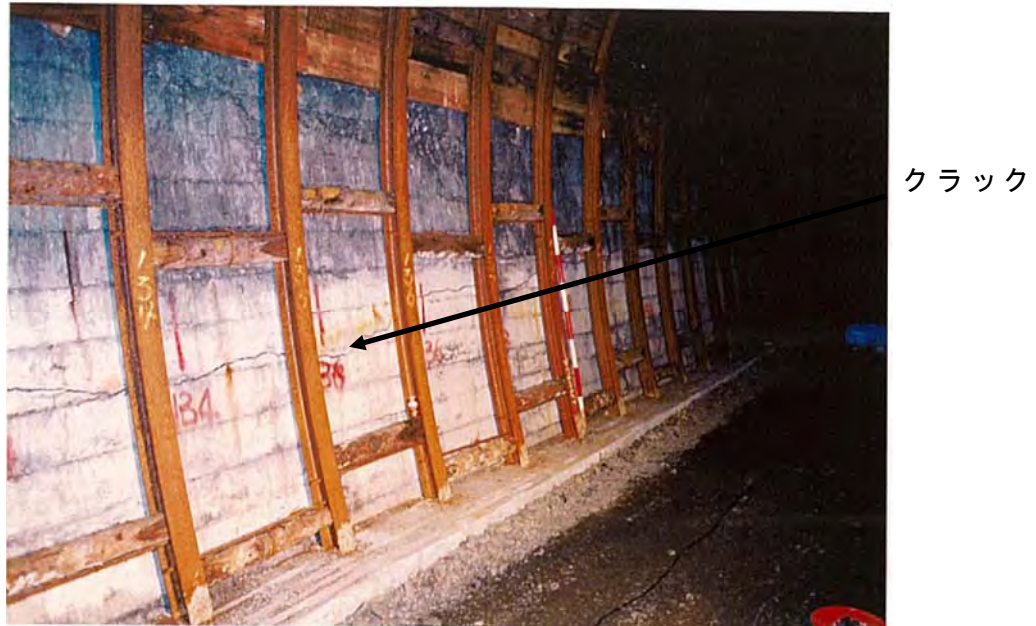
Photo4.1.9 既設トンネル SP210 付近左側の状況
