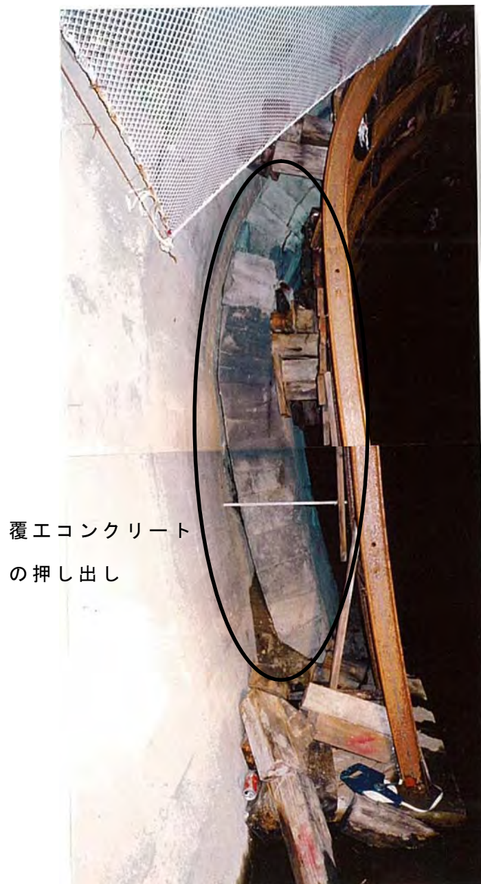
Photo4.1.20 既設トンネル SP391 付近右側の状況
