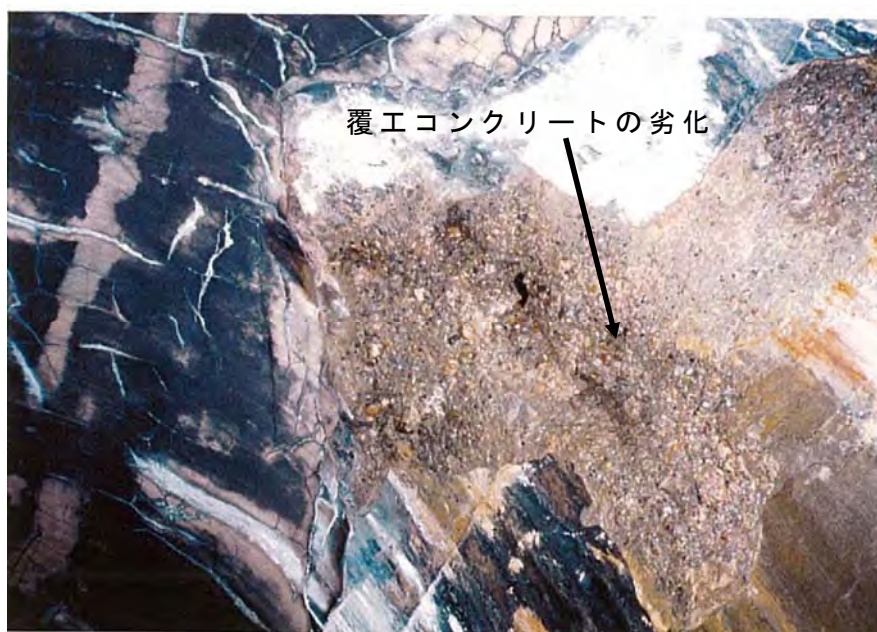
Photo4.1.22 既設トンネル SP450 付近左側の状況
