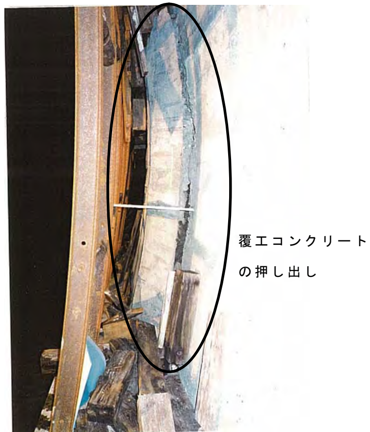
Photo4.1.19 既設トンネル SP391 付近左側の状況
