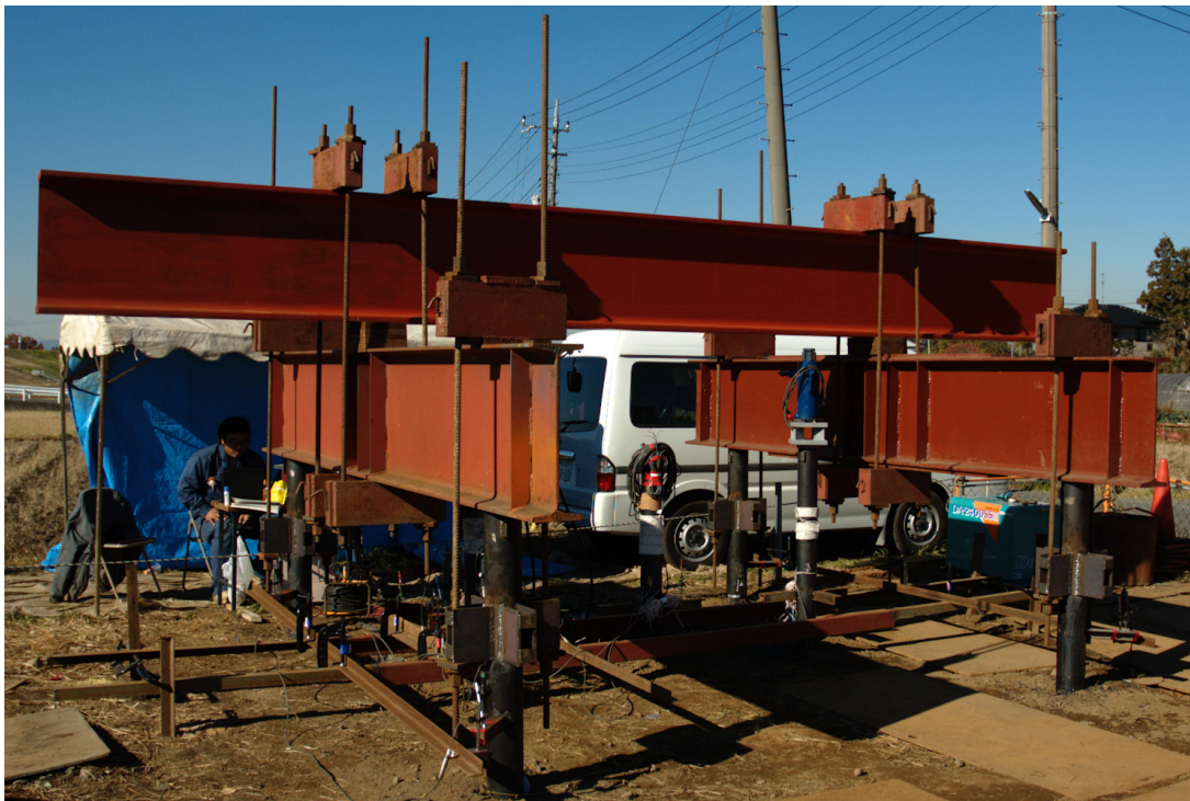
写真 4.1 載荷試験装置全景
