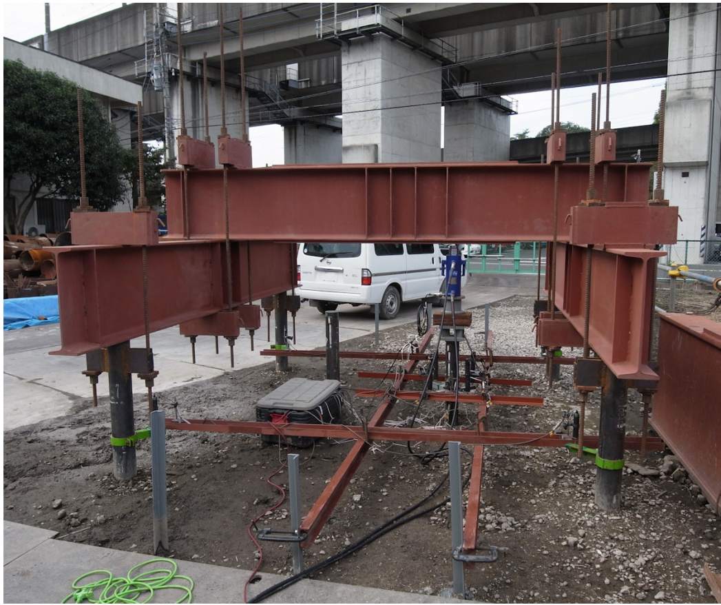
写真 5.1 載荷試験装置全景
