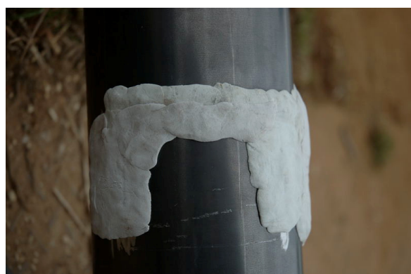
付写真 4.3 ゲージ養生状況
