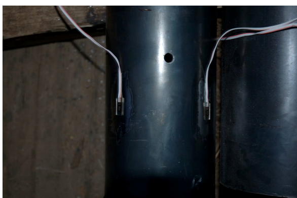
付写真 4.2 ゲージ貼付状況
