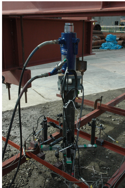
写真 5.2 杭頭付近状況
