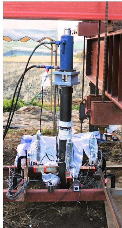
写真 4.2 載荷試験装置 杭頭付近状況
