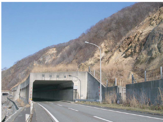
写真-1.1 ロックシェッドの一例
