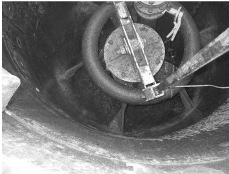
付写真 3.6 節部清掃状況 (地上部でのキャリブレーション)
