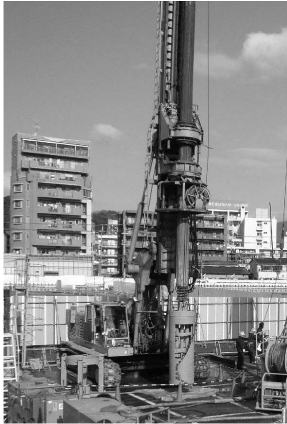
付写真 1.1 アースドリル掘削機
