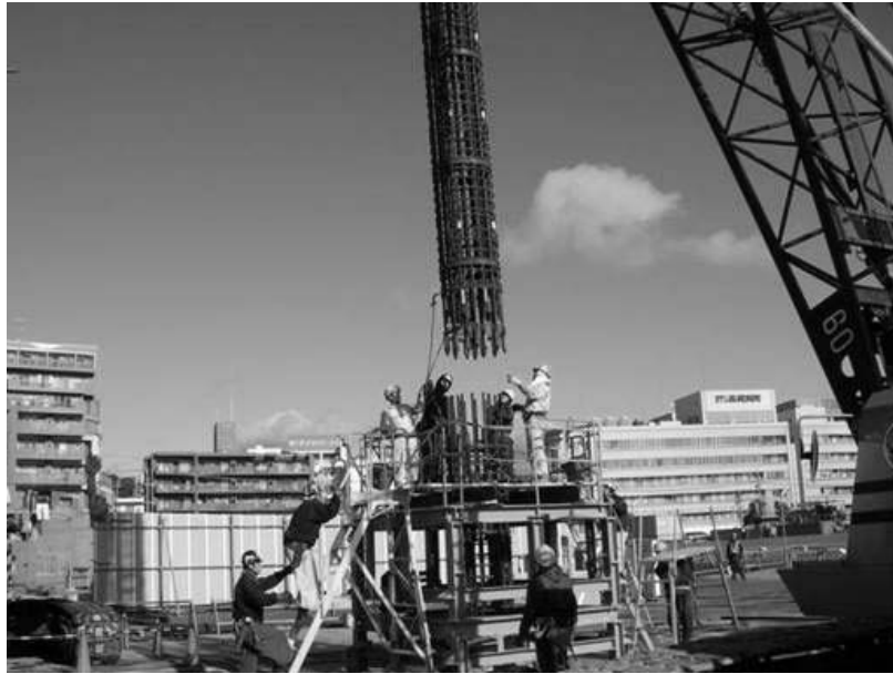
付写真 3.9 鉄筋かごジョイント
