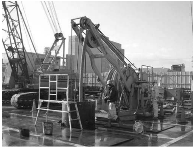
付写真 3.5 節部清掃装置
