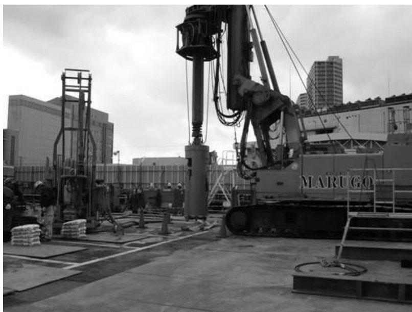
付写真 3.3 節部の掘削
