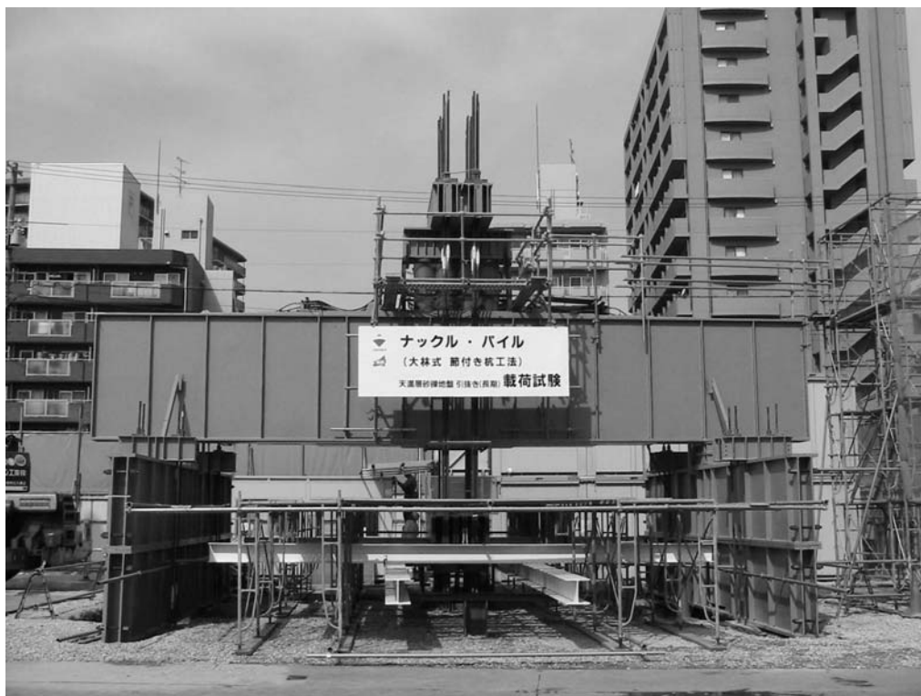
写真 2.2.2 引抜き試験状況 (A-1)
