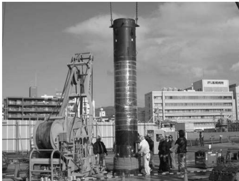
付写真 3.8 フリクシオンカットの鋼管
