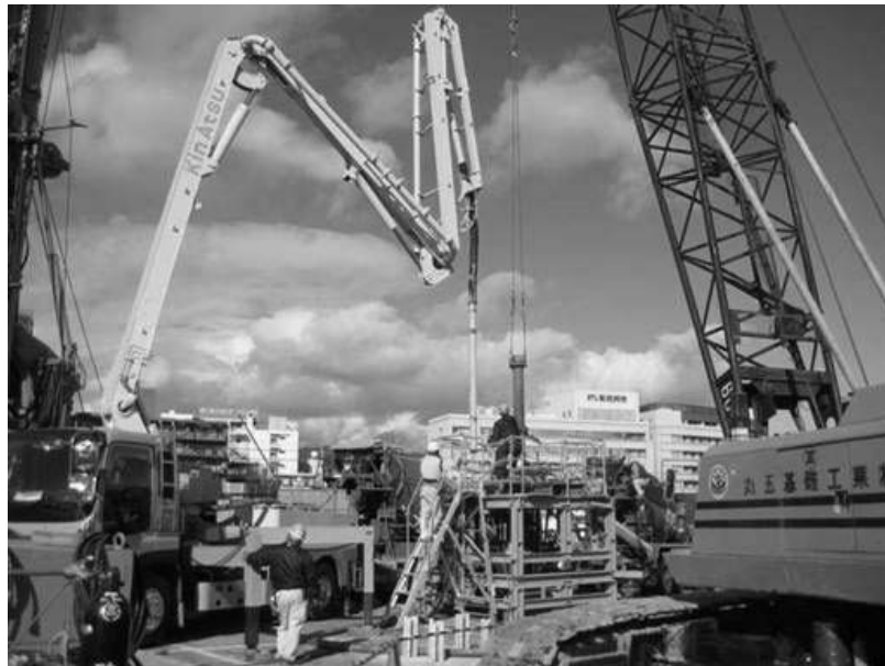
付写真 3.10 コンクリート打設
