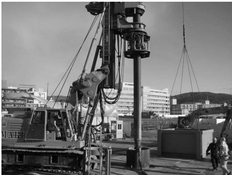
付写真 3.2 軸部の掘削
