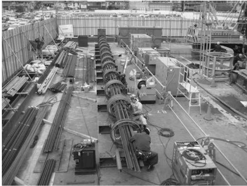
付写真 3.1 試験体の鉄筋かご組立
