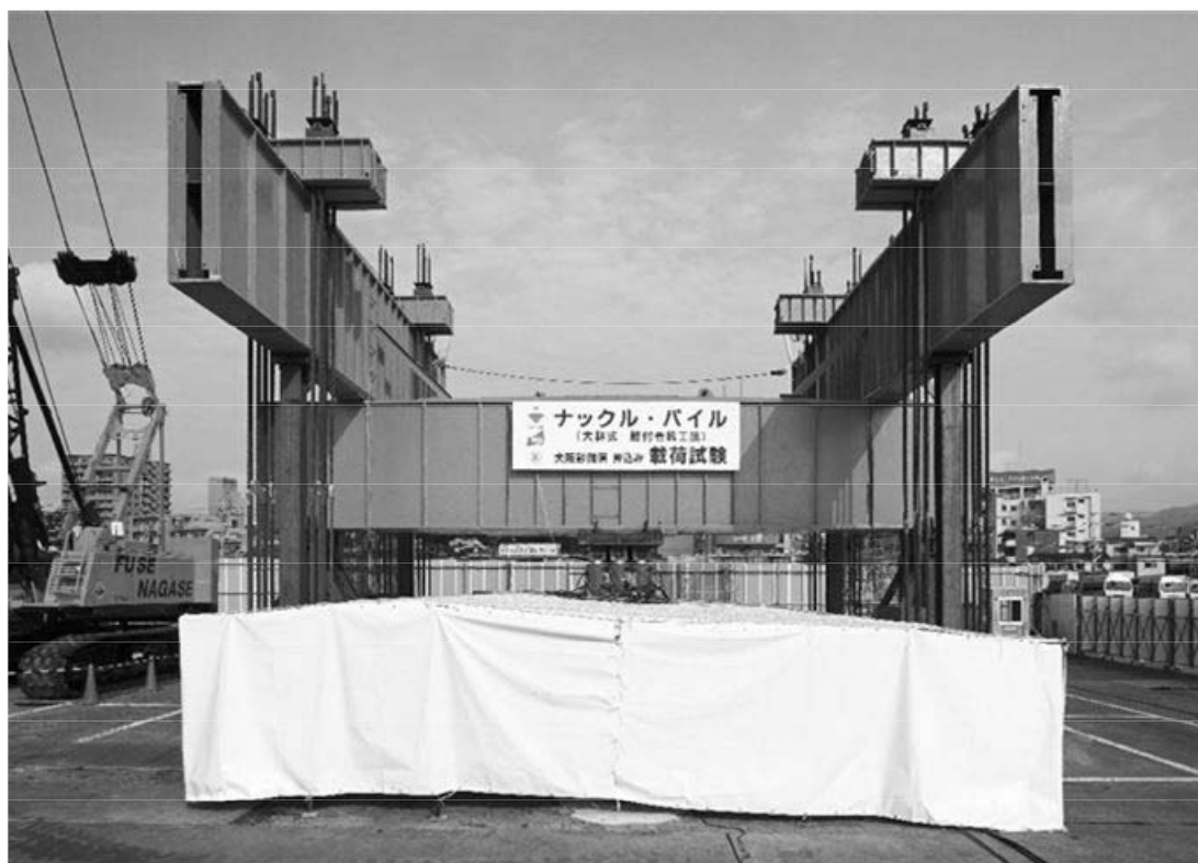
写真 2.4.1 押し込み試験状況 (B-1)
