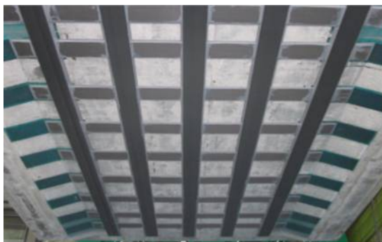
写真 4-4 CFRP プレート接着状況
