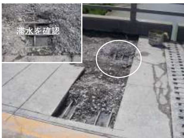
写真 1-2 床版上面の砂利化現象
