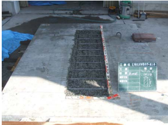
(a) WJ 施工後
