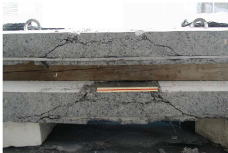
(b) 切断面におけるな斜めひび割れの例
