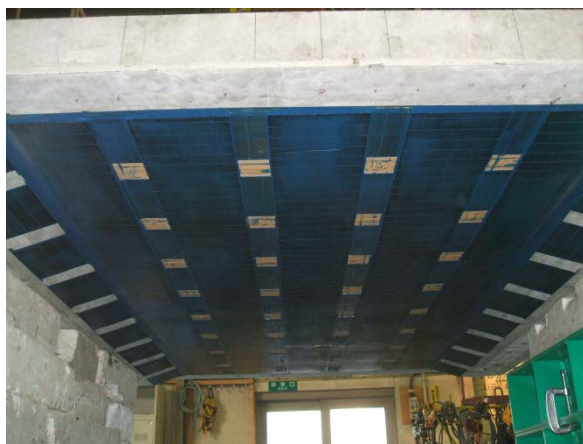
(c) CFRP シート接着後
