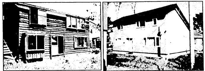
写真1 TK邸外観(改修前)
