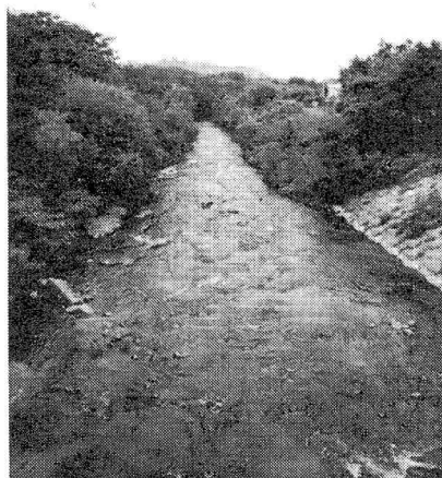
写真-3 改修区間
