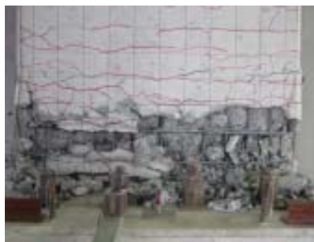
写真 - 3 2.0-R-3 試験体損傷状況
