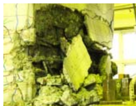
写真 - 4 2.0-R-5 試験体損傷状況
