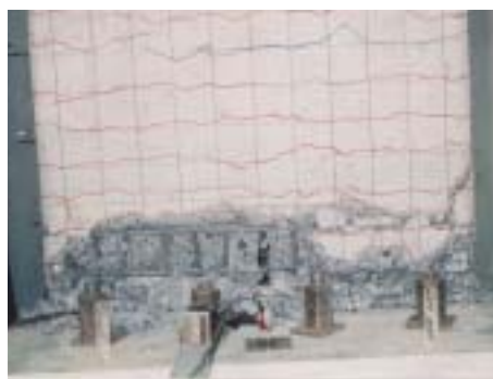
写真 - 2 2.0-N 試験体損傷状況
