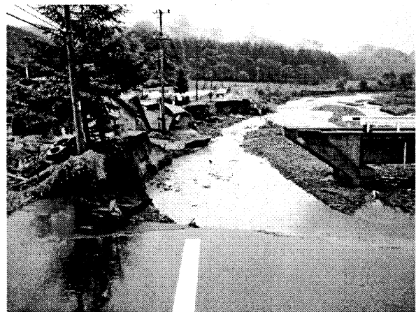
図-4 貫気別川河岸浸食による道道の被災(北海道提供)
