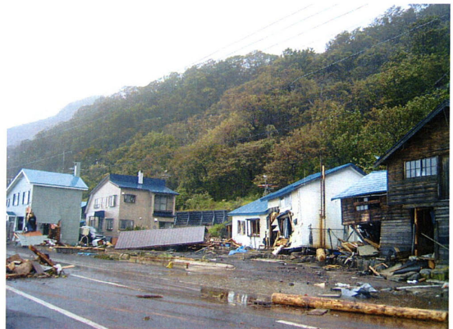
写真-1 越波による家屋被害状況
