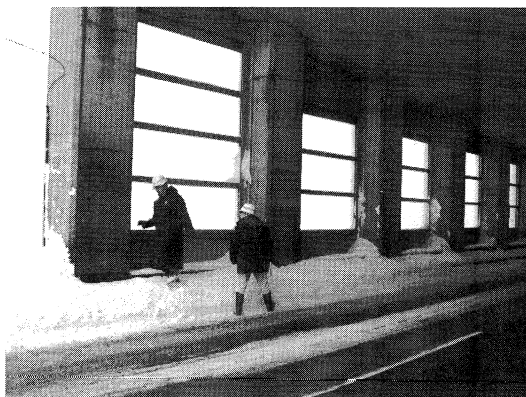
写真-3 アラミド繊維シートの施工例
