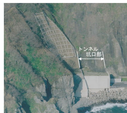
写真-1 トンネル坑口部
