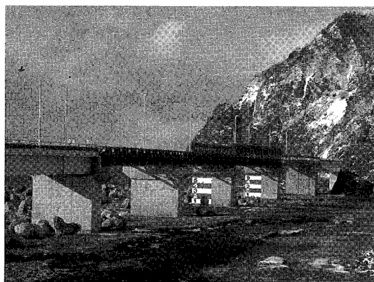
写真-2 仮橋(トラス橋)
