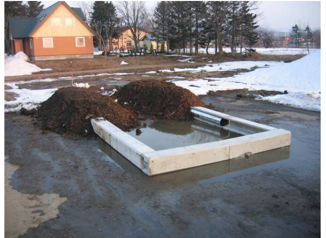
Fig.3.2 雪下の実験装置設置状況
