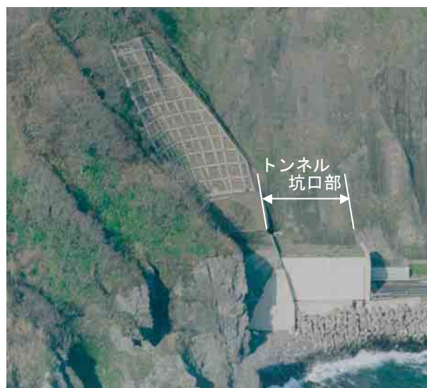
写真-1 トンネル坑口部の例
