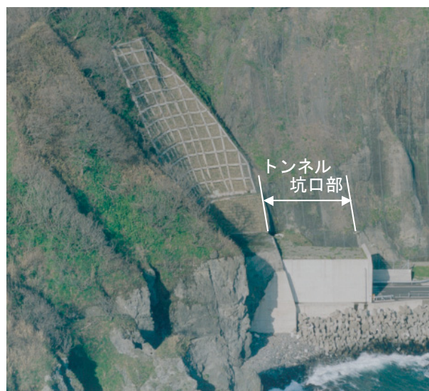
写真-1 トンネル坑口部の例
