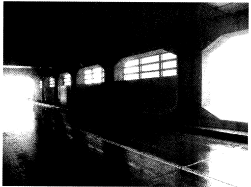
(b) 覆道内の状況
