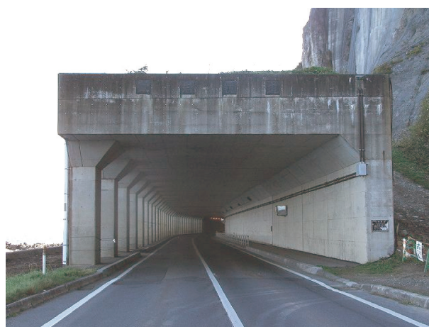
写真-1 落石防護覆道の例
